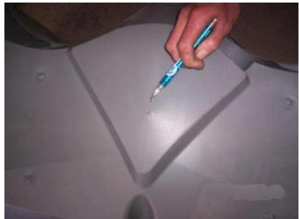
**2.2.** Utilizando un sacabocados de 3", se deberá de perforar en el punto anteriormente ubicado. Colocando la válvula sobre la perforación, marcan los orificios correspondientes a los 4 tornillos, utilizando una broca la cual no supere el grosor del tornillo de la válvula, perforan dichas marcas.
