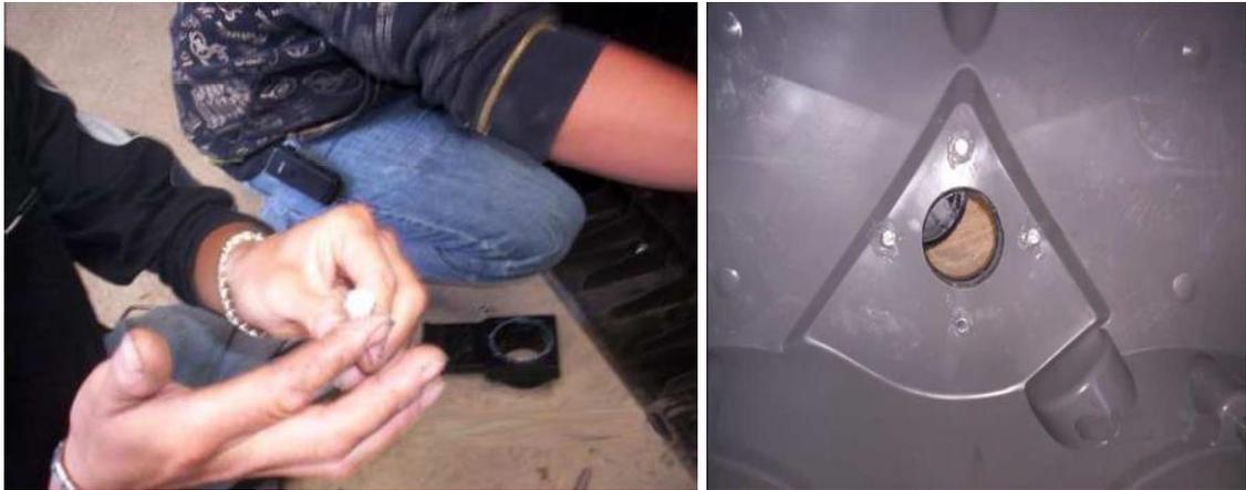
**2.5** Se coloca la válvula sobre el depósito donde previamente se han puesto los tornillos de la misma, también se coloca el cuello y se comienza a ajustar con las tuercas.
