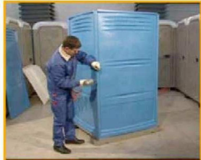
**1.11 Inserte la tercera pared y fijación completa de las 3 paredes con los remaches verticales y los remaches inferiores.**
