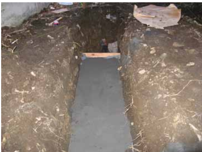
Fotografía No. 3 Relleno de zanja con arena
