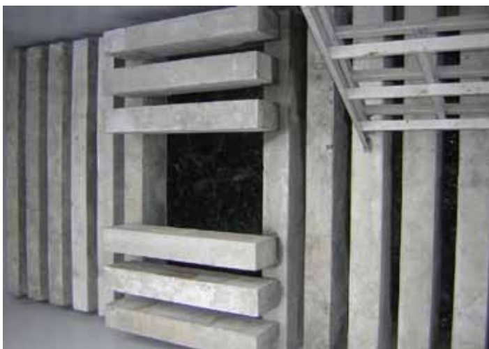
Fotografía No. 11 Travesaños de soporte.
