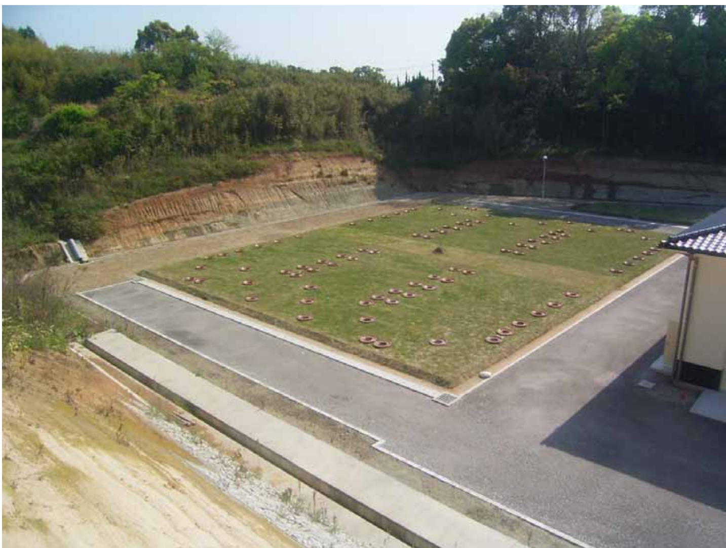
Fotografía No. 50 Obra terminada
