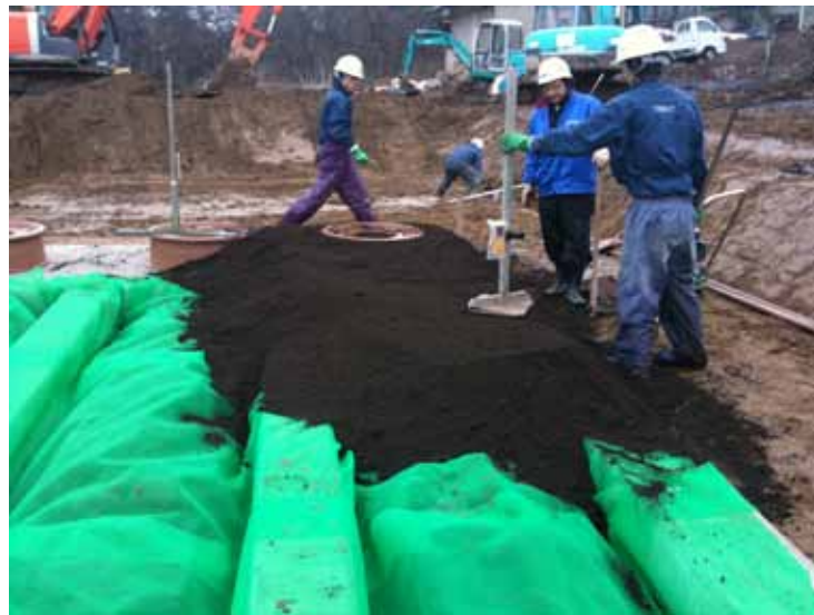
Fotografía No. 48 Nivelación de cubierta vegetal
