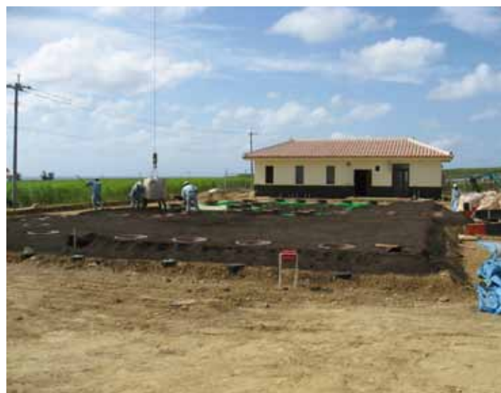
Fotografía No. 17 y No. 18 Colocación de cubierta vegetal
