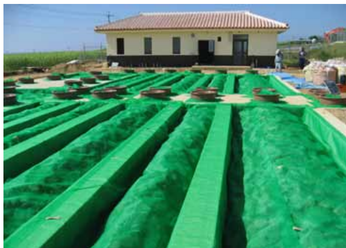
Fotografía No. 15 Instalación de la malla
