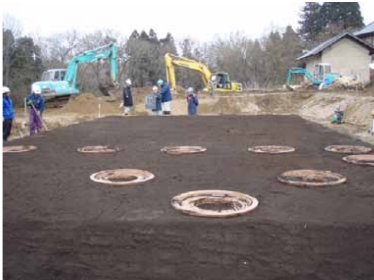
Fotografía No. 46 Colocación de cubierta vegetal
