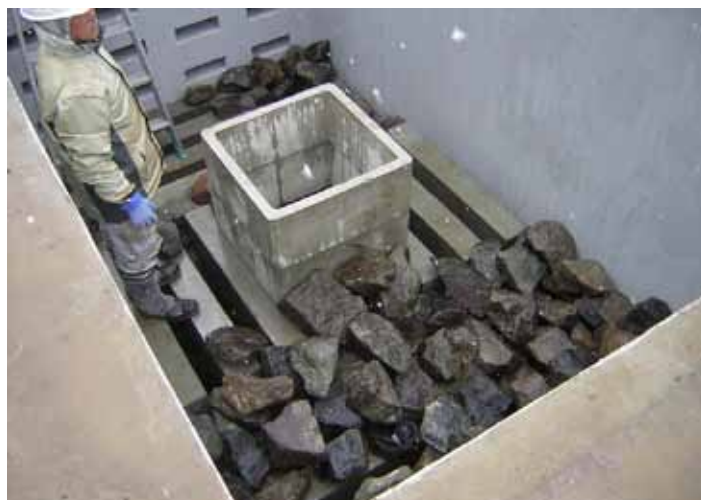
Fotografía No. 12 Colocación de grava lecho inferior
