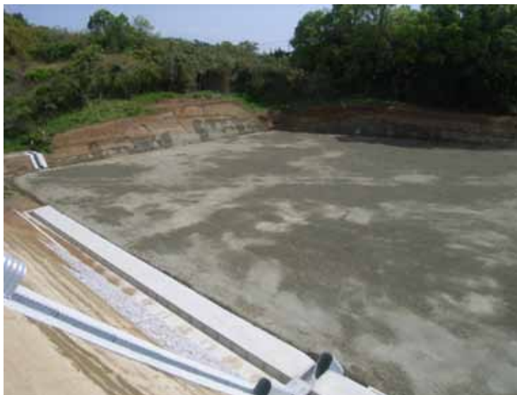
Fotografía No. 19 Trazo y nivelación de obra
