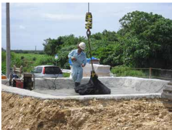
Fotografía No. 39 Transporte de grava de contacto
