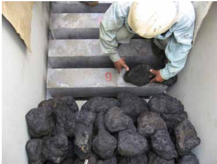
Fotografía No. 42 Colocación de grava
