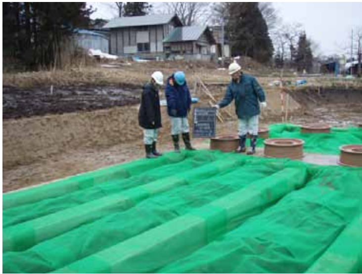
Fotografía No. 44 Colocación de malla
