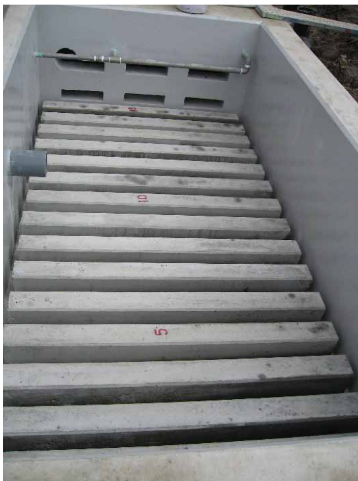
Fotografía No. 37 Trabe de soporte instalada
