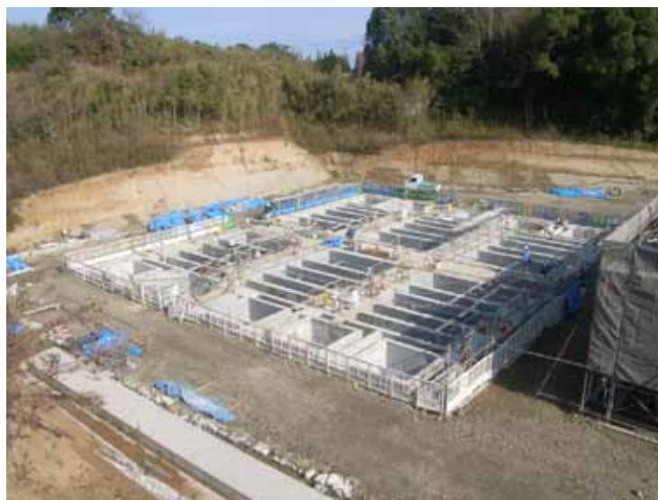
Fotografía No. 38 Distribución de grava de contacto
