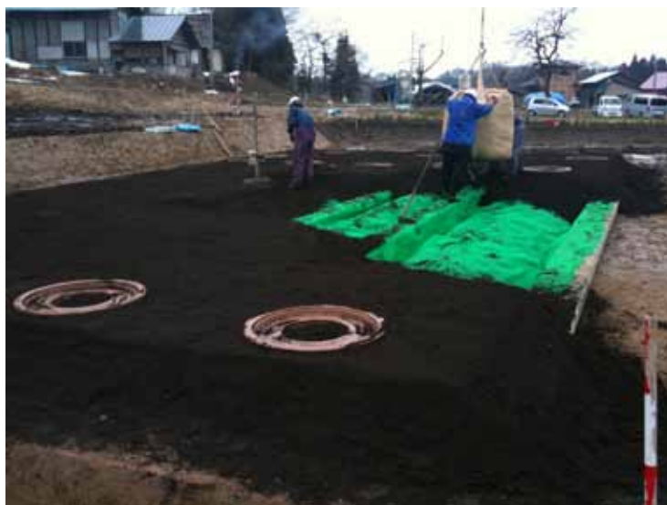
Fotografía No. 49 Comprobación de espesor de tierra
