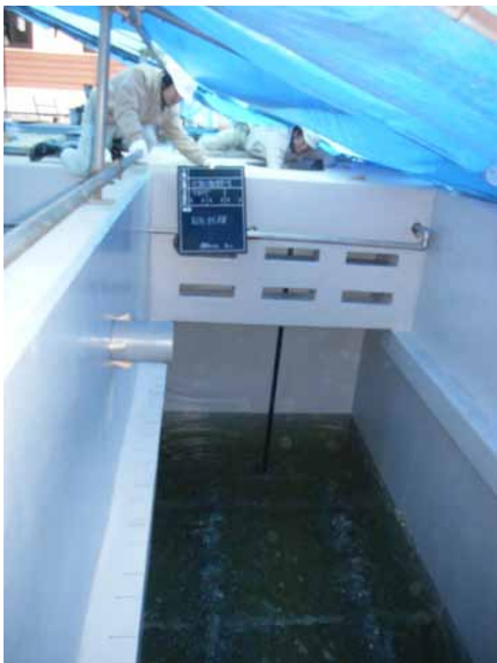
Fotografía No. 29 y No. 30 Pruebas del sistema de distribución de aire en sedimentadores
