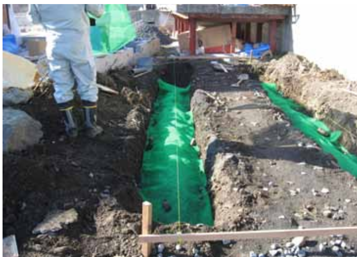
Fotografía No. 6 Instalación de malla en forma cóncava
