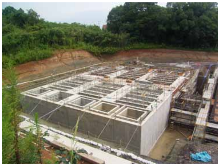
Fotografía No. 27 Colado de concreto en losas
