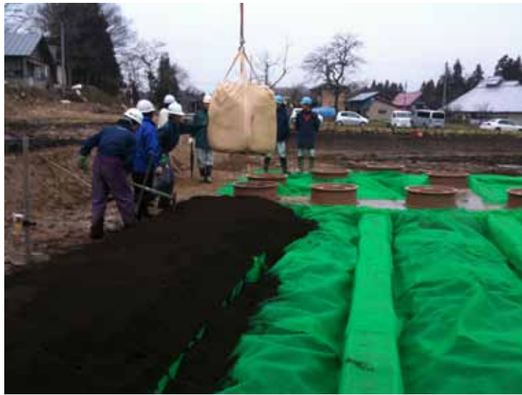
Fotografía No. 47 Relleno con cubierta vegetal
